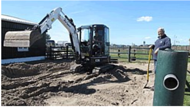
De graafmachine aan het werk
